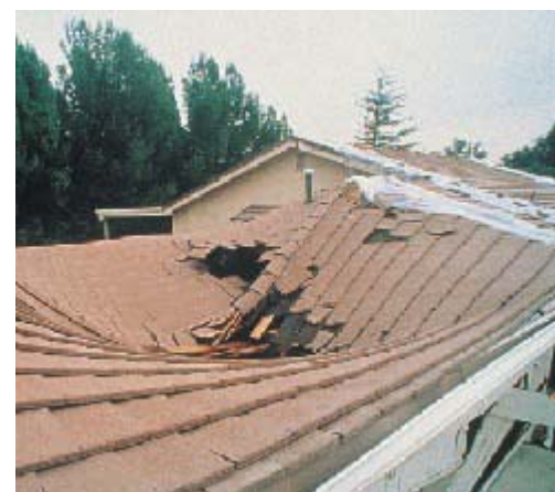
ЦЕМЕНТАЯ ЧЕРЕПИЦА СМЕСТИЛАСЬ, ЧЕМ ВЫЗВАЛА ПОВРЕЖДЕНИЕ СТРУКТУРЫ ДОМА
