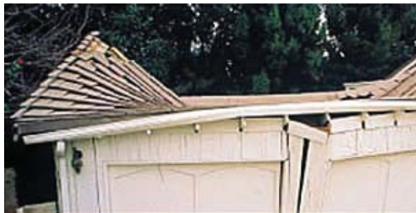
Снимки сделаны после сильного землетрясения в Northridge, Калифорния 1994 г. Фото тяжелой крыши (справа) и легкой металлической кровли GERARD (слева) были сделаны на одной улице
