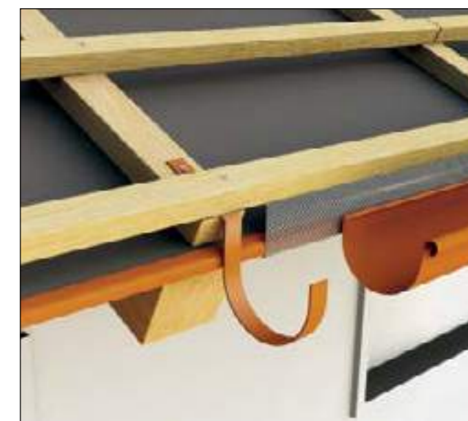
Вариант 1: Капельник уходит за водосток
